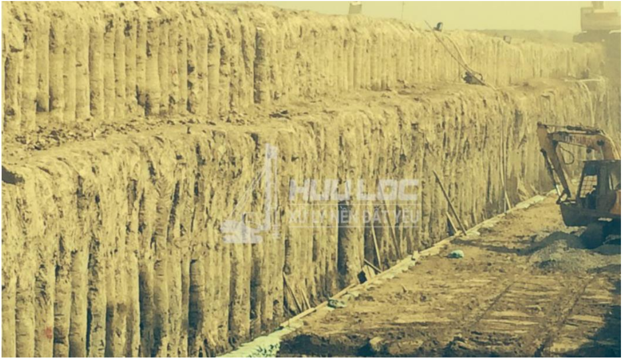
Hình 1.4. Công trình bảo vệ bờ sông bằng cọc đất trộn xi măng
