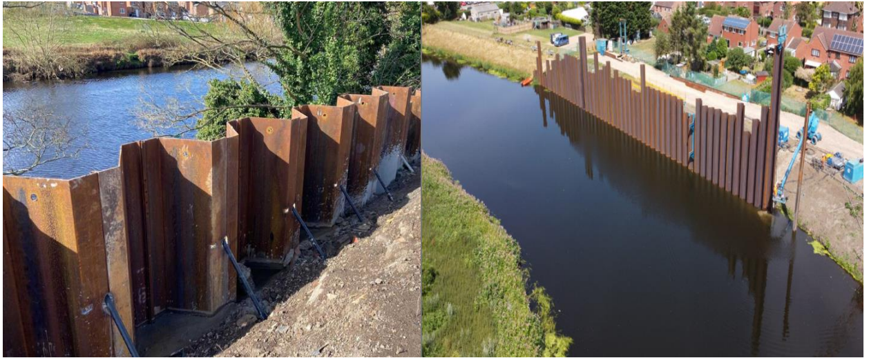
Hình 1.5. Tường cừ bản bằng thép bảo vệ bờ sông chống sạt lở
