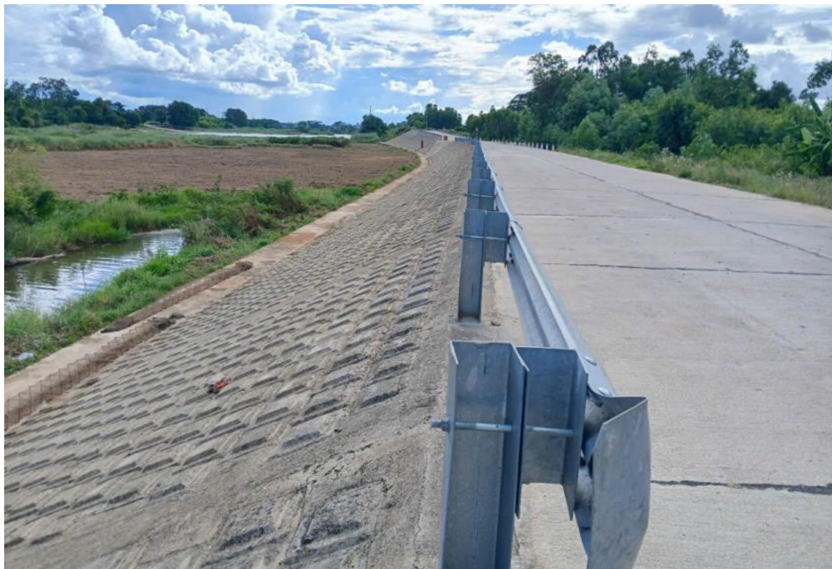
Hình 1.1. Kè chống sạt lở bờ sông Ba đoạn qua thôn Phong Niên, xã Hòa Thắng, huyện Phú Hòa
