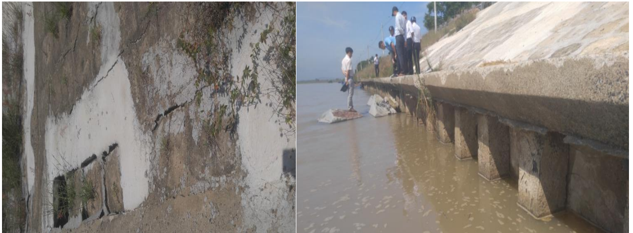
Hình 1.13. Hình ảnh Kè sông Ba qua thôn Phú Lộc bị mất ổn định
