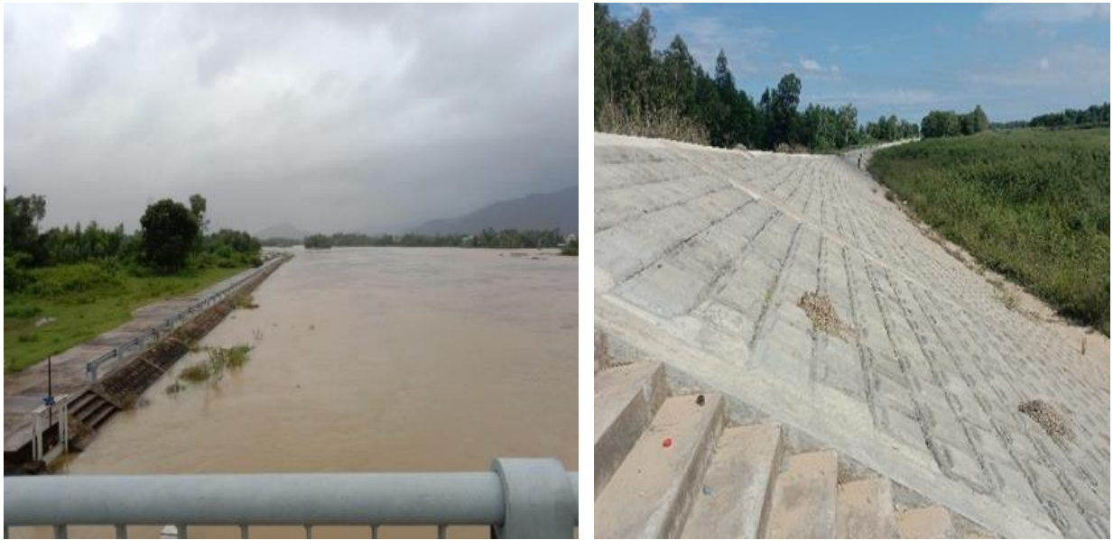
Hình 1.3. Kè chống xói lở bờ tả sông Bàn Thạch, đoạn từ Phú Đa đến cầu Bàn Thạch, thị xã Đông Hòa
