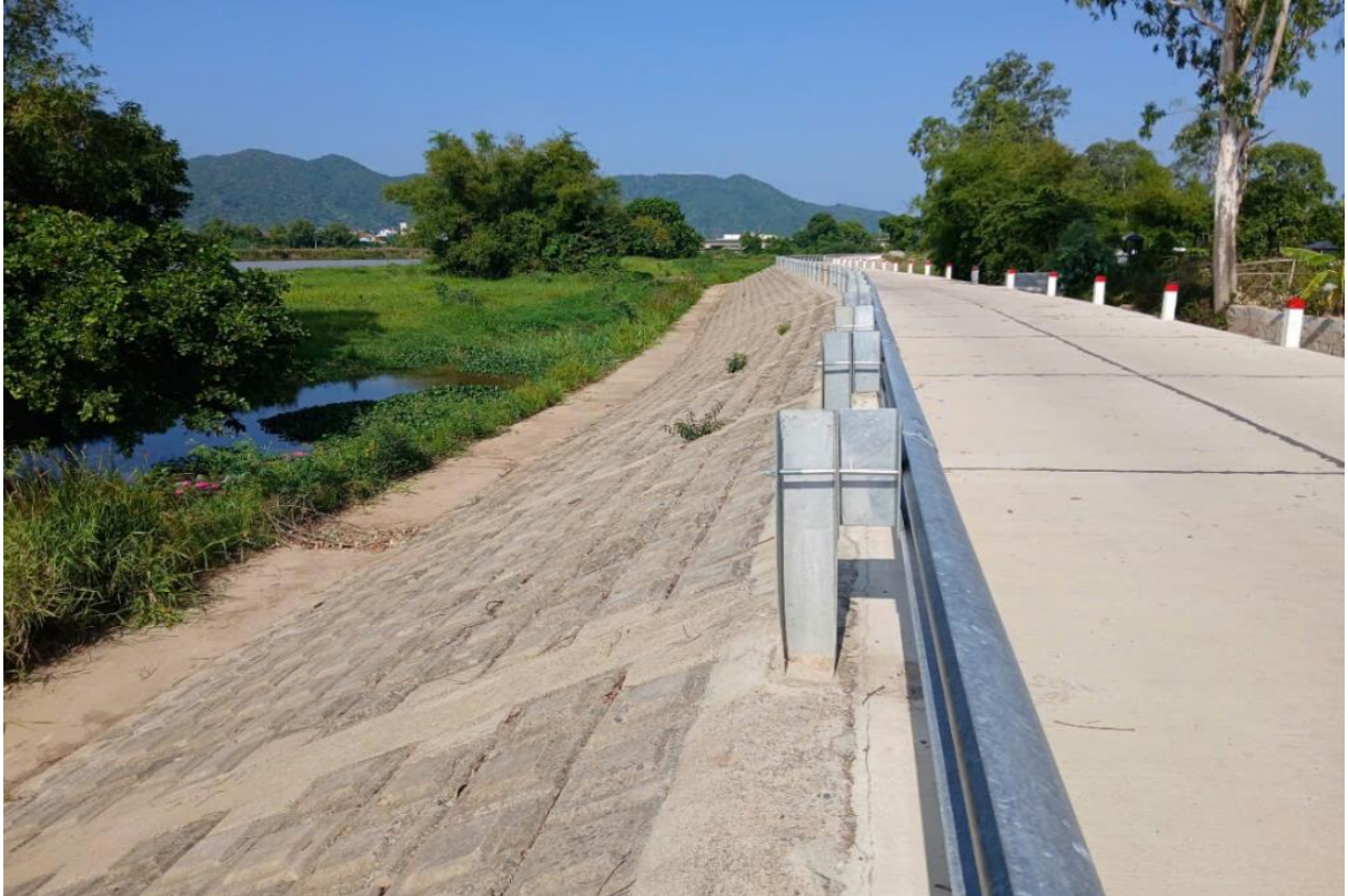
Hình 1.2. Kè chống xói lở bờ sông Ba đoạn qua thị trấn Phú Thứ, huyện Tây Hòa
